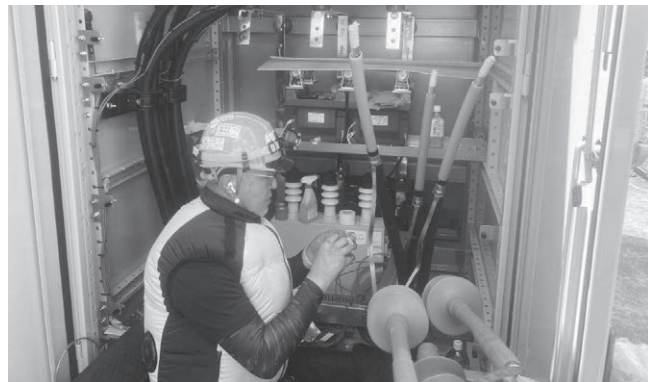
<現場作業風景写真>
