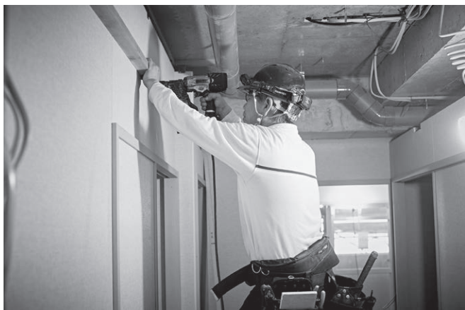
(内装プレハブ工法による施工)
