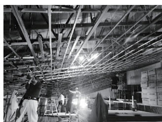
軽鉄下地工事
