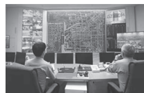
「交通管制センター」
